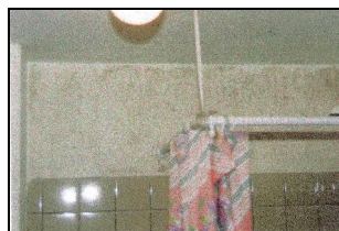
Bild 03: Badzelle mit Außenwand, vorher
