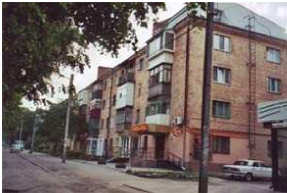
Bild 4: Ältere Wohngebäude aus Ziegel in der Вул. Пирогова in Вінниця (Ukraine)
